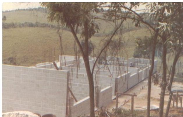
**Figura 11 – Levantamento das paredes**
